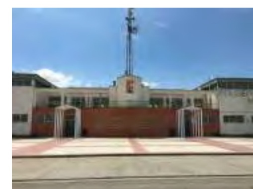
VISTA 06. FACHADA PRINCIPAL PABELLÓN POLIDEPORTIVO
